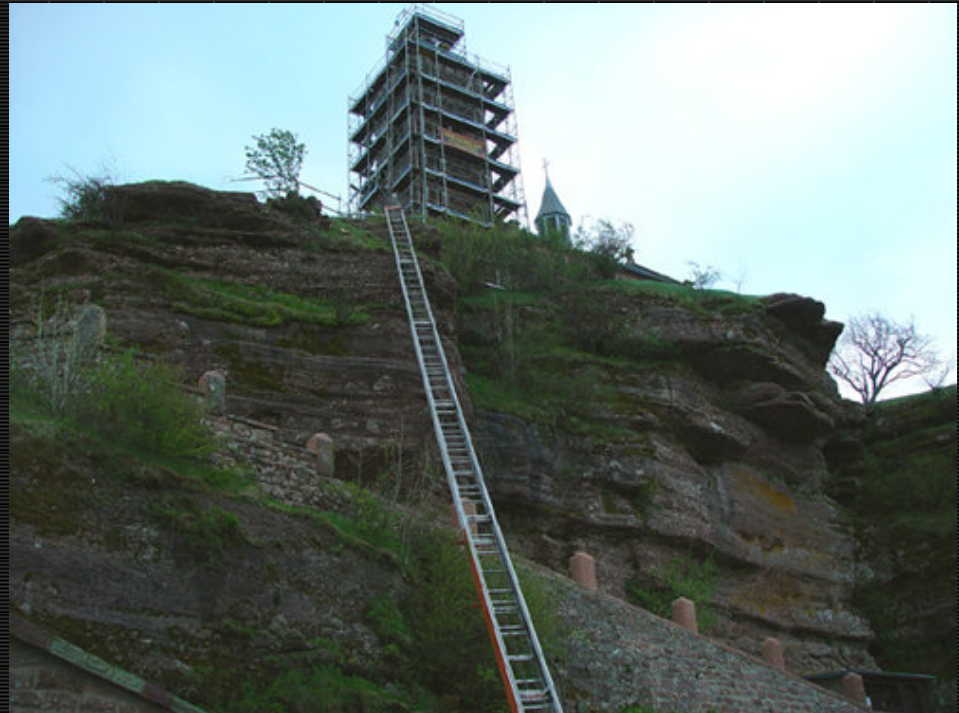
L'échafaudage en place sur la tour de la chapelle et l'élevateur destiné à monter les matériaux.
